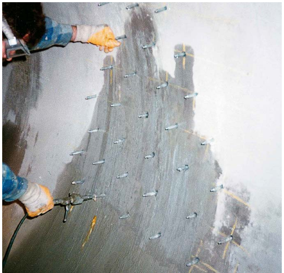
Rasterinjektion mit Schraubpackern
